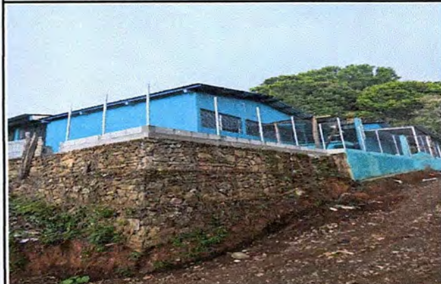
Foto 4: Mejoramiento de la escuela Finalizada
