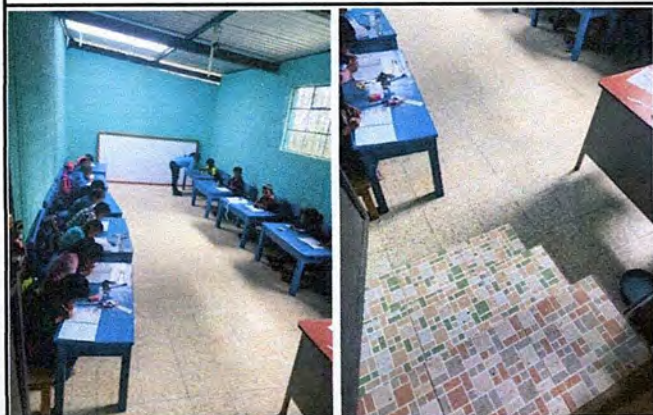
Foto 3: Mejoramiento de piso
